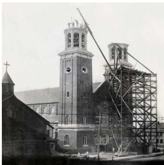
Budowa kościoła Assumption w Buffalo (proszę zwrócić uwagę na drabinę po której wychodzili budowniczcy na najwyższą wieżę) (źródło: buffaloah.com )
